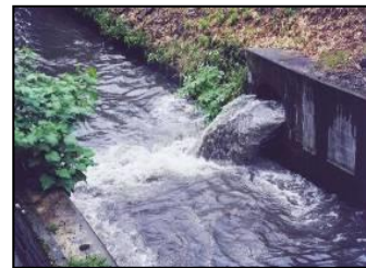
写真 9：合流式下水道からの雨天時放流水
