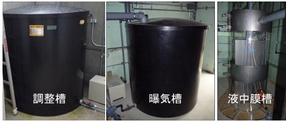
写真5 膜分離活性汚泥法を適用した浄化槽A
