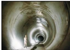
写真 7：広瀬川第 2 雨水
