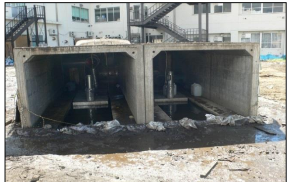
採熱室・熱交換器(雪山内部ボックスカルバート)
