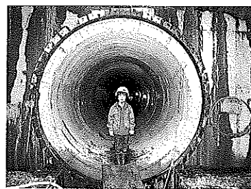
大口径の雨水バイパス管
