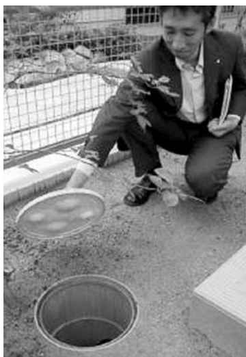
雨水浸透ます設置の状況
