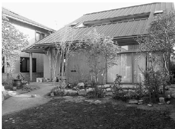
写真1 完成した直後の雨水ハウス
