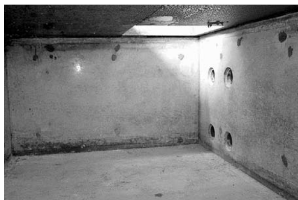
写真2 基礎を兼用したコンクリート製の地下貯留タンク
