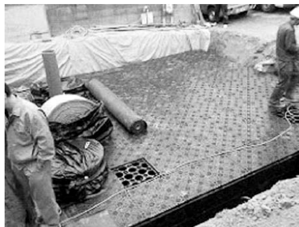
写真3 庭下の防災用地下貯留タンク （アクアブリック：タキロン（株）提供）
