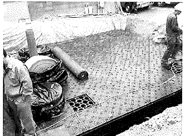
写真3 庭下の防災用地下貯留タンク （アクアブリック：タキロン（株）提供）
