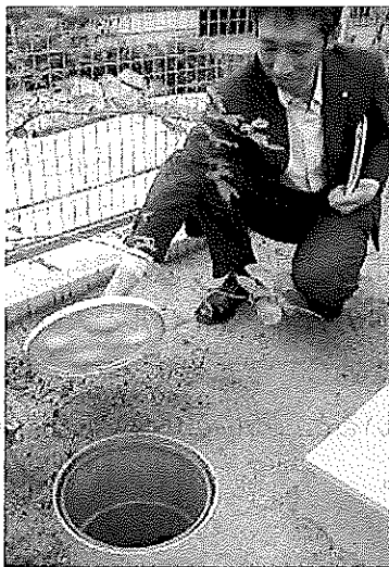
雨水浸透ます設置の状況
