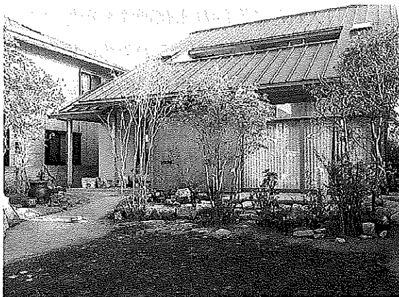
写真1 完成した直後の雨水ハウス
