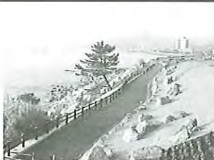
公共緑化工事
